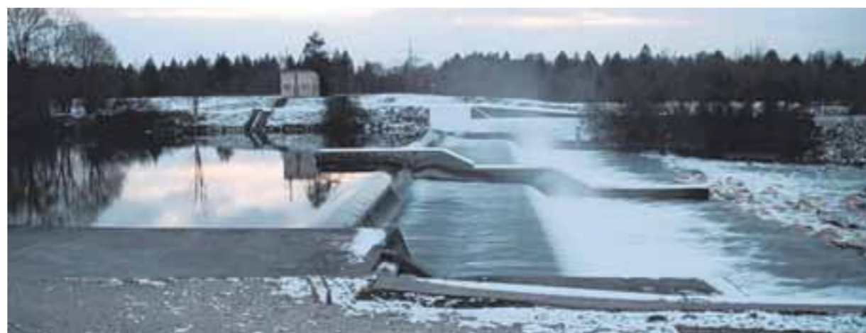
E.on möchte ein neues Lechkraftwerk bei Kissing bauen.
