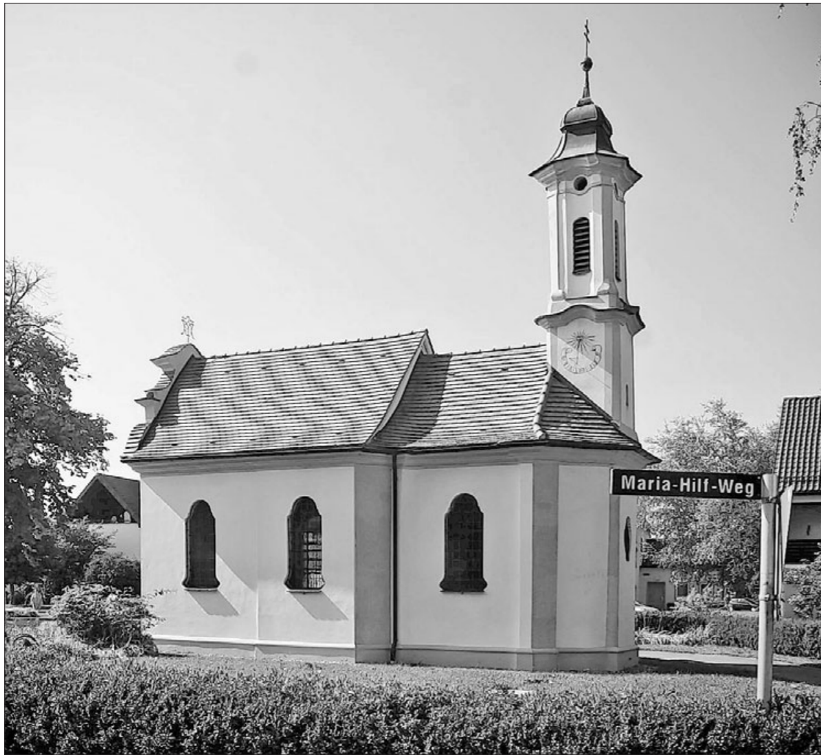
Baujahr 1760 und dank eines Freundeskreises wieder gut in Form: Die Maria-Hilf-Kapelle in Senden-Ay. Der Verein hat sich der Sanierung des Rokoko-Bauwerkes verschrieben. Am Samstag feiert er sein 25-jähriges Bestehen. FOTO: MATTHIAS KESSLER
